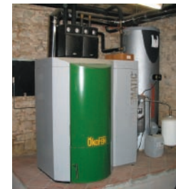
chaudière à granulés de bois
